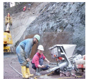
Injektion von Selbstbohrankern
